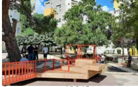
Chantier éducatif ADDAP avec 3 jeunes. Réalisation aménagements transitoires sur la place des Gradins à Arles
