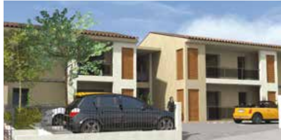
RUE LAMANON - MALLEMORT ↑ 5 LOGEMENTS (3 PLUS - 2 PLAI) - Architecte : LPJ Architecture
